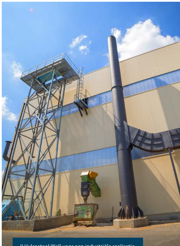
Jl Vulcasteel Wall voor een industriële realisatie.
