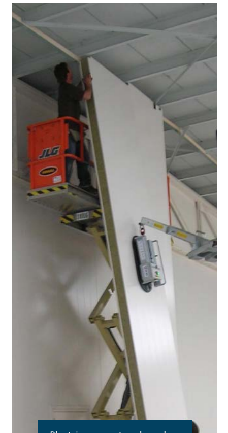
Plaatsing van rotswolpanelen.
